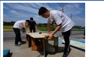
8,9月 改修工事 職人や学生 による工事
